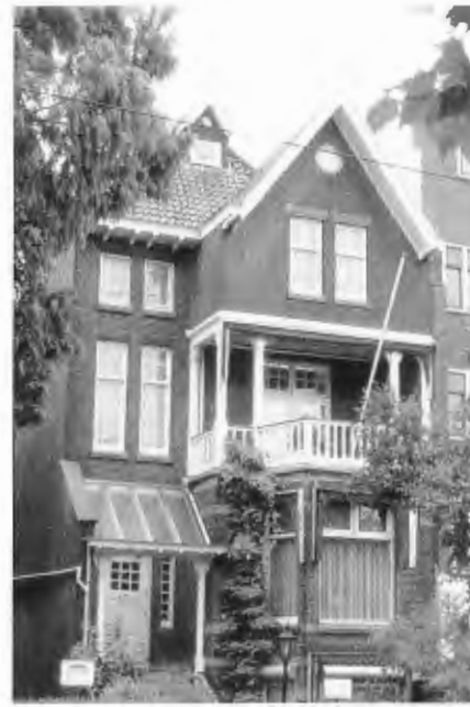
Pand Oudedijk 7, Rotterdam
